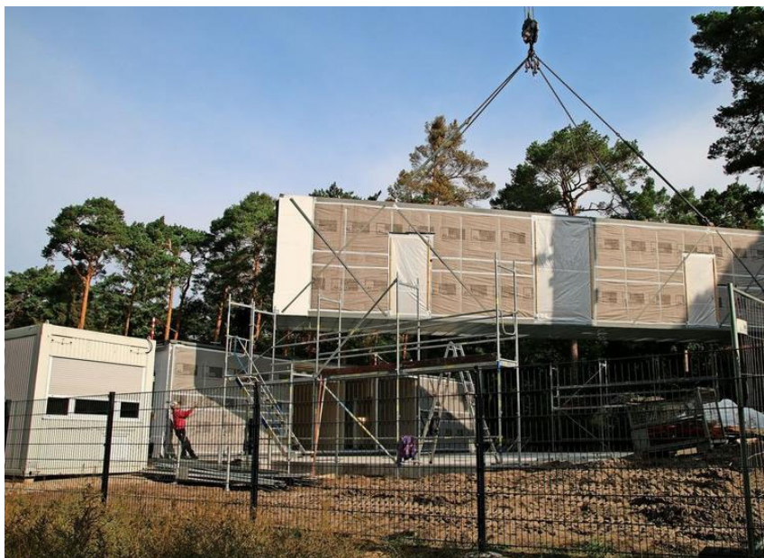
In Rangsdorf wird der neue Hort neben der Oberschule mit vorgefertigten Modulen aufgebaut. Quelle: Lisa Neugebauer
